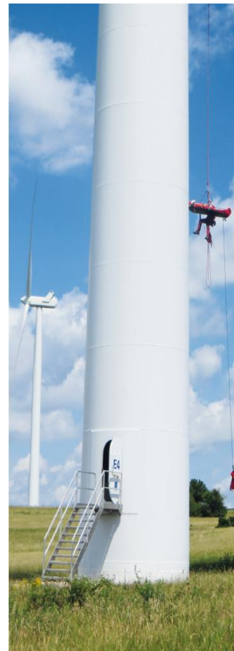
Exercice d'évacuation de blessé avec les pompiers à Marcellois (21) (Source EDPR)
