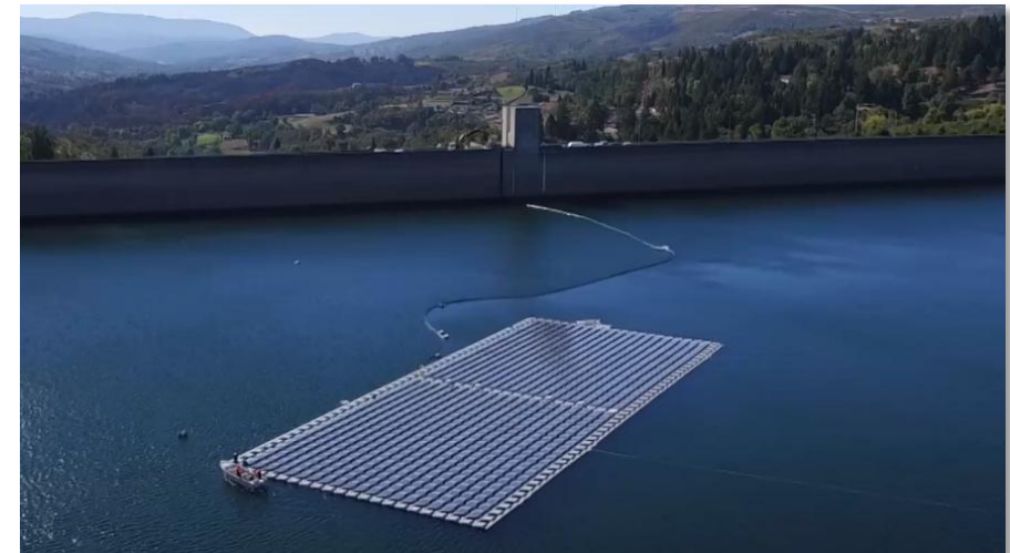
Centrale solaire flottante (source EDPR - Portugal)
