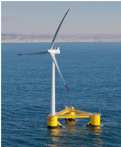
Prototype d'éolienne flottante mise en service au Portugal par EDPR (source EDPR)
