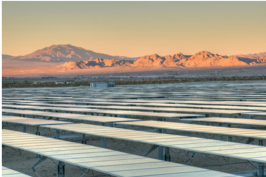
Centrale solaire sur tracker 1 axe (source EDPR - USA)
